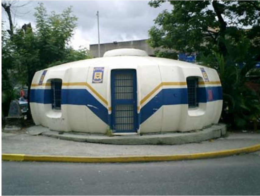
Figura S2-8.7 Módulo Usado en Baruta como Estación de Policía
